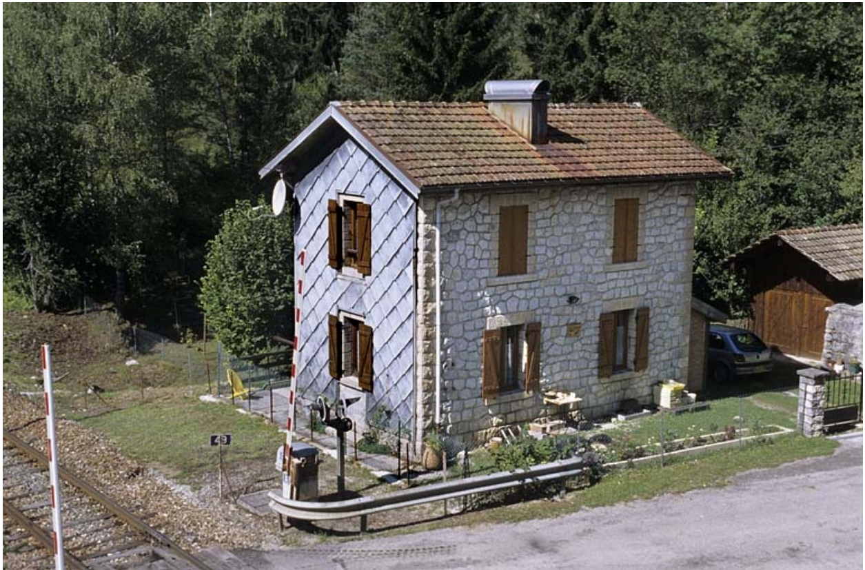
Façades antérieure et latérale gauche (côté voie).
