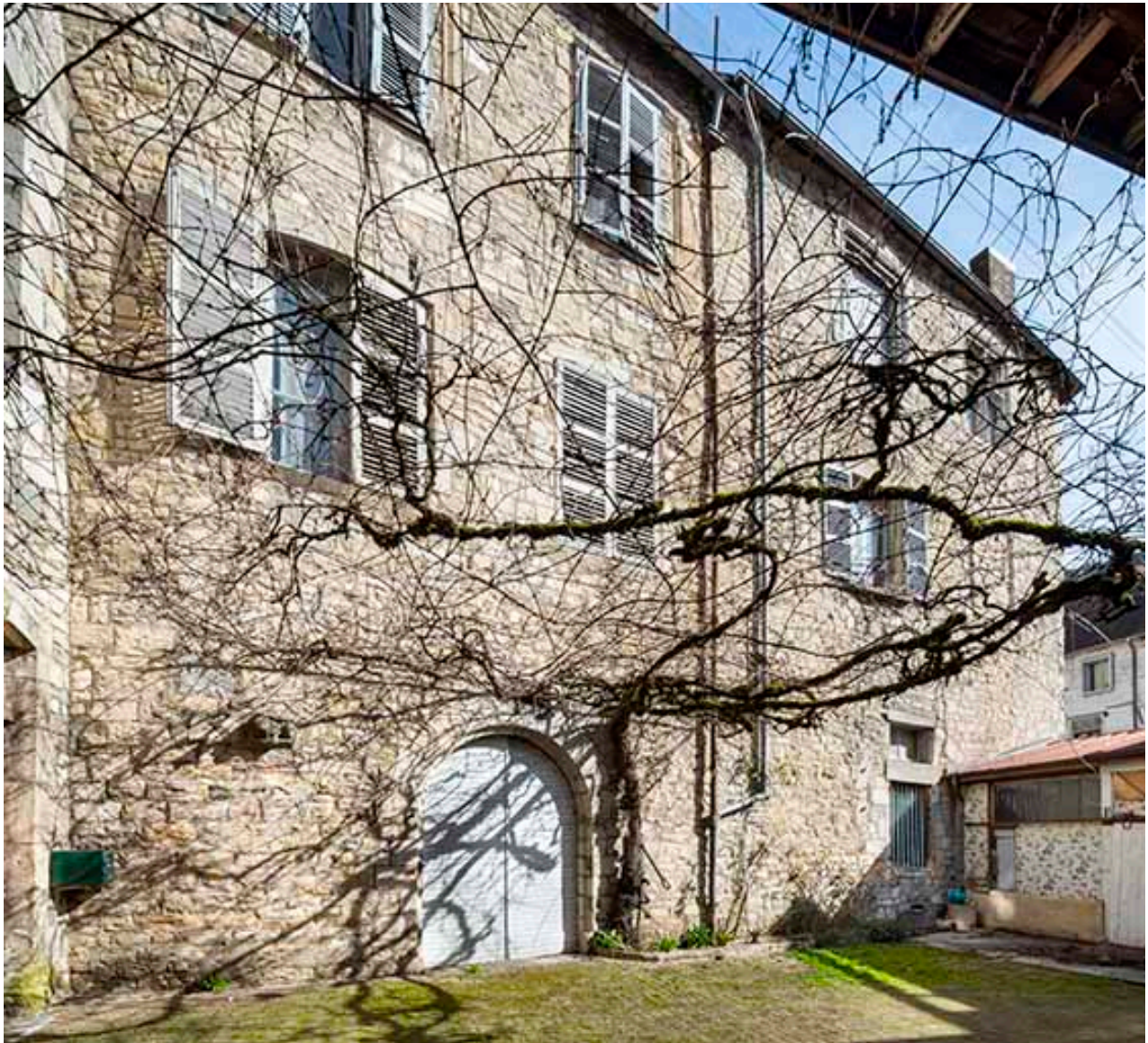
Façade sud (à gauche) depuis la cour de l'hôtel de Falletans.
