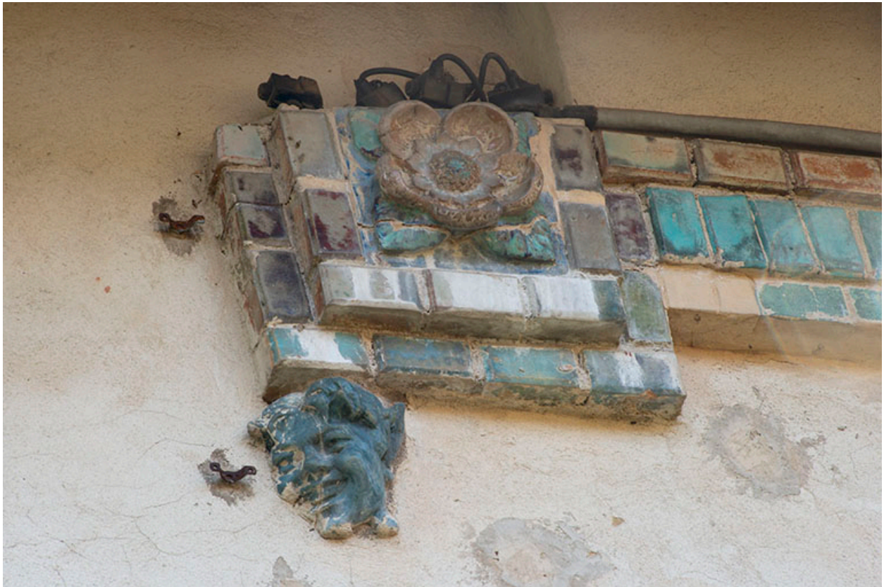
Façade nord. Extrémité de la frise.
