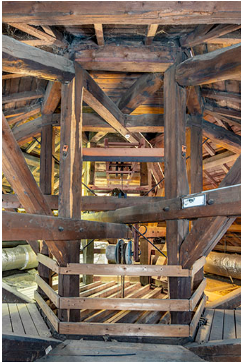
Grand Kursaal, comble : partie centrale de la charpente, avec le treuil du grand lustre.
