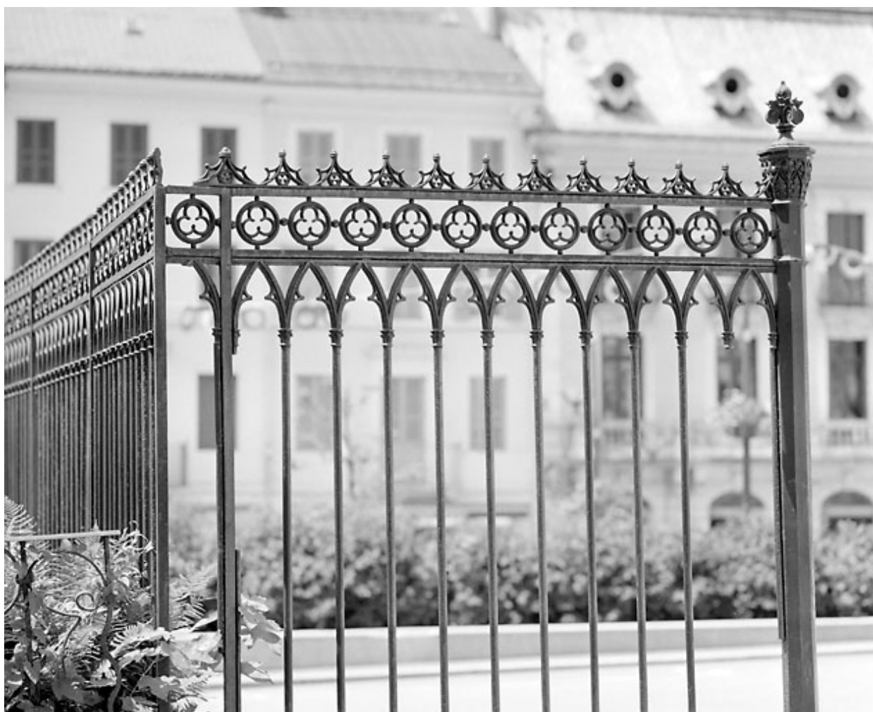
Travée fixe, côté presbytère : partie haute.
