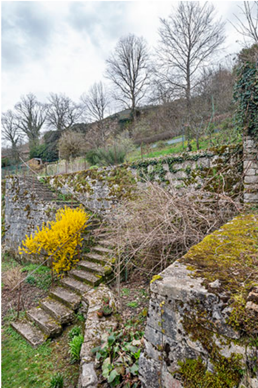
L'escalier d'accès à la première terrasse.
