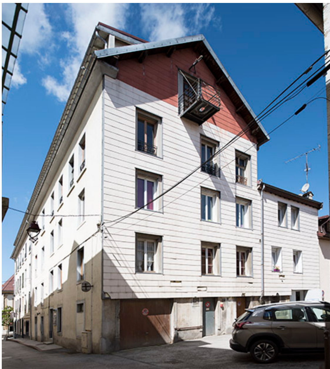
Façades postérieure et latérale droite.
