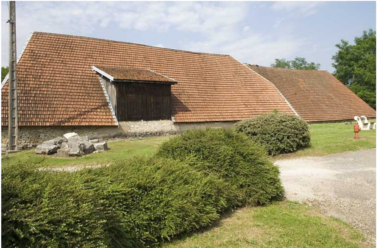
Vue d'ensemble de la halle à charbon.
