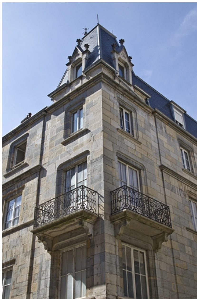
Vue rapprochée de l'angle du logis principal.
