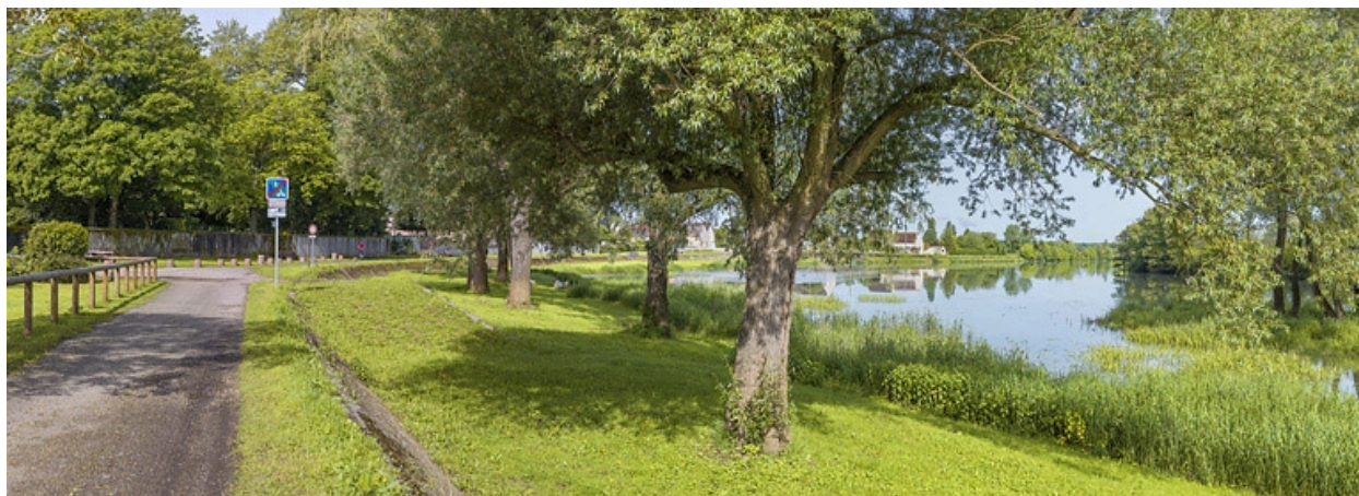
Digue et village.
