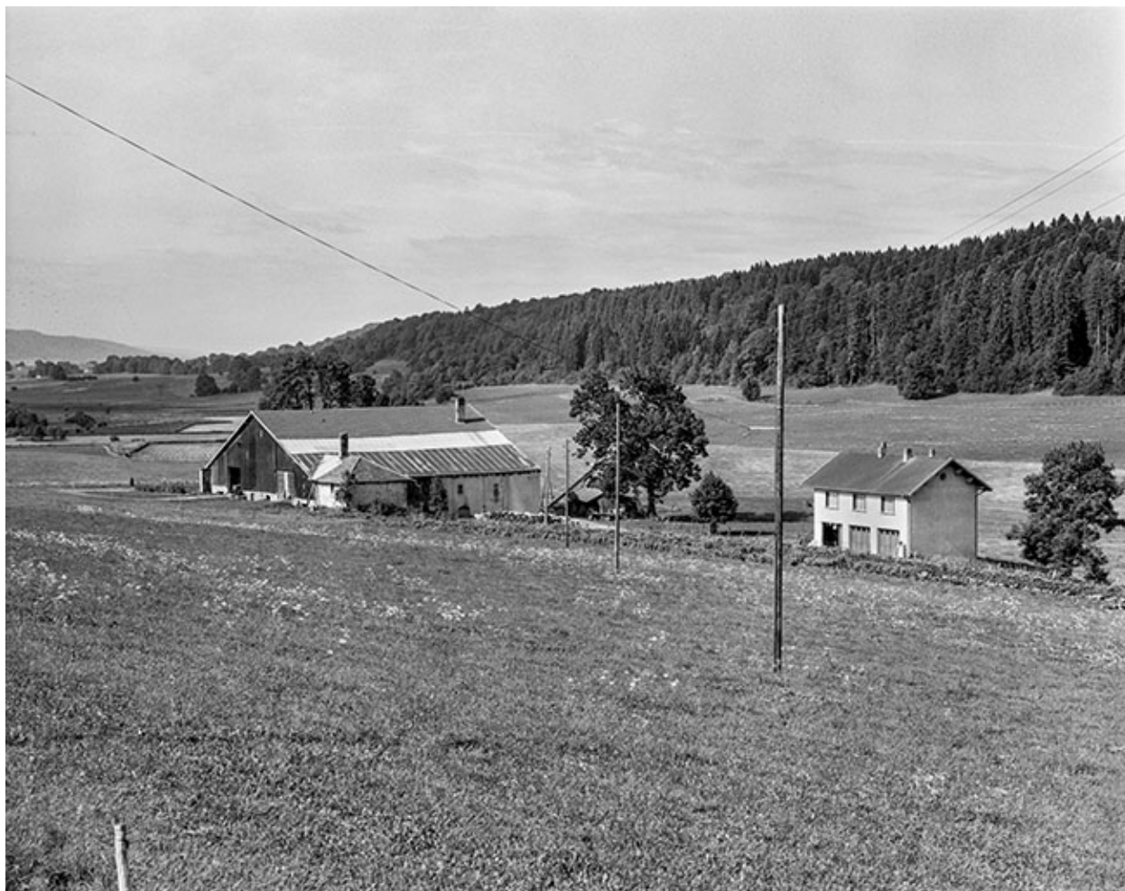
Vuillecin : ferme située au lieudit Saint-Lazare.
