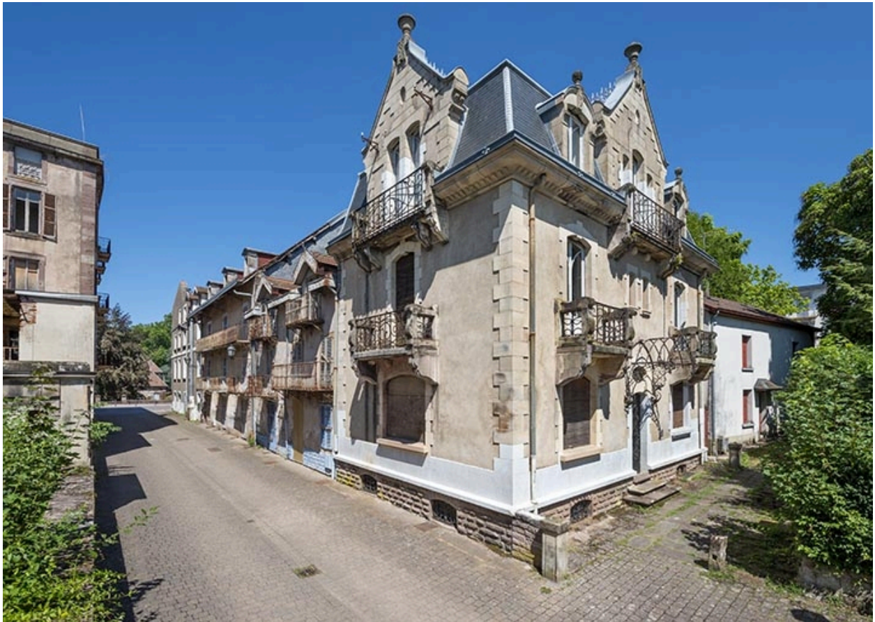
Vue d'ensemble depuis l'allée des Romains.
