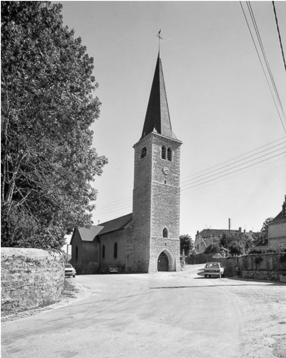
Façades antérieure et latérale gauche.
