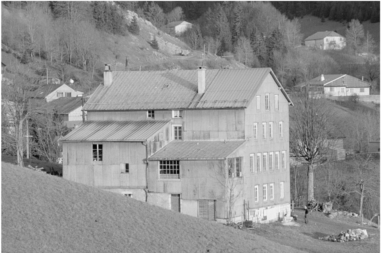
Façades postérieure et latérale droite.
