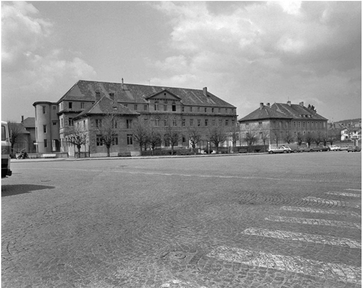
Façade antérieure, vue de trois quarts gauche.
