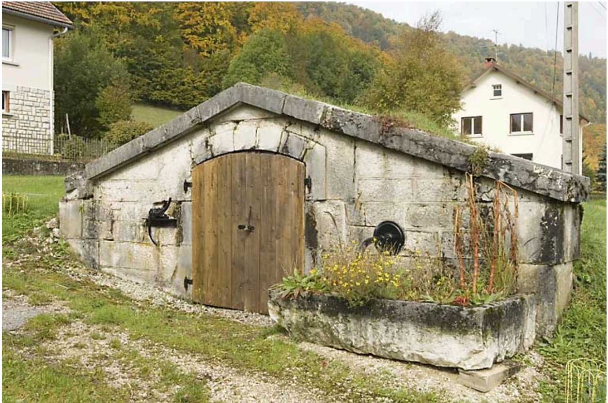
Réservoir des Maillots, de trois quarts droite (rue du Bois, 2008 AE 109).
