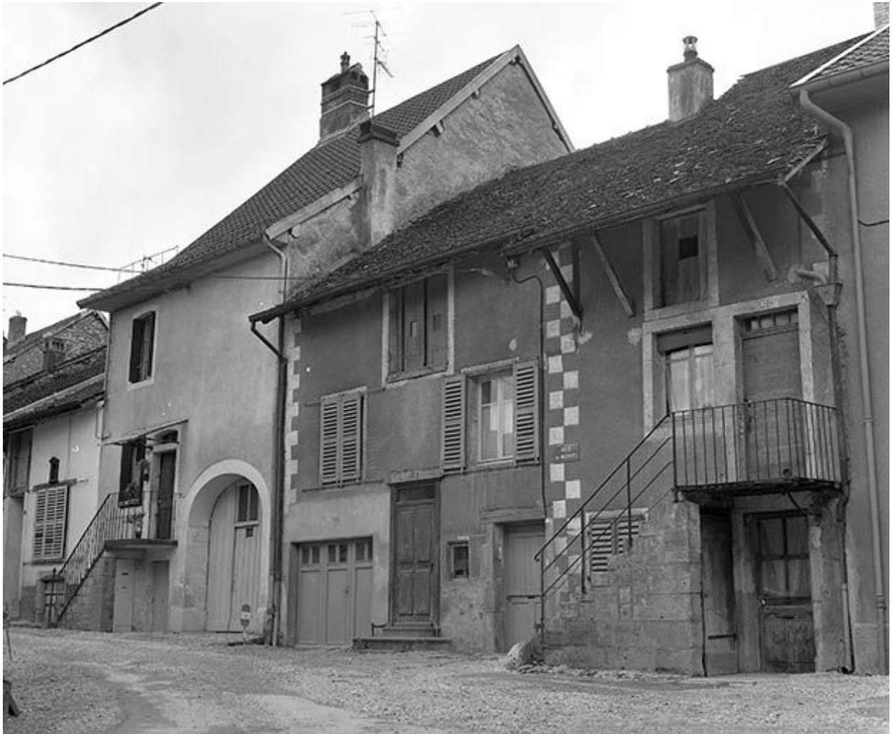
Maisons 13 à 17 rue des Martinets : vue générale.
