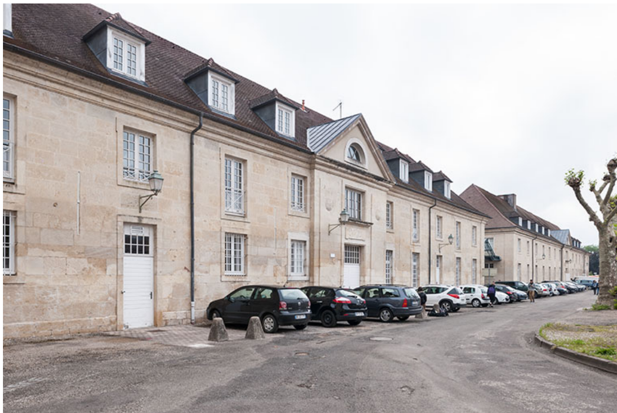
Bâtiment atelier-logement : façade postérieure, vue 3/4.
