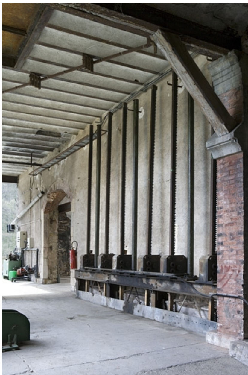
Bâtiment d'eau. Vue rapprochée du système Fontaine.
