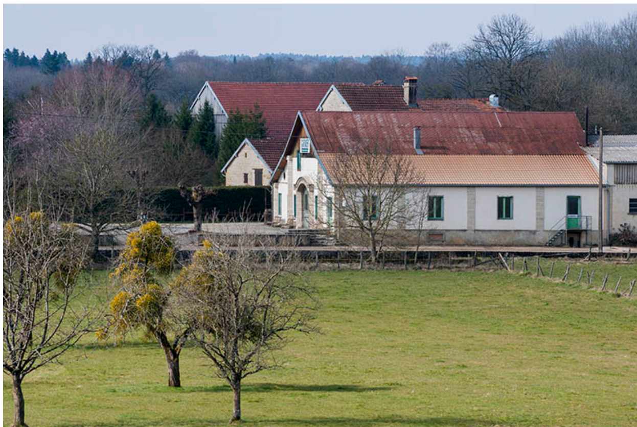
Façade nord de l'atelier de fabrication.
