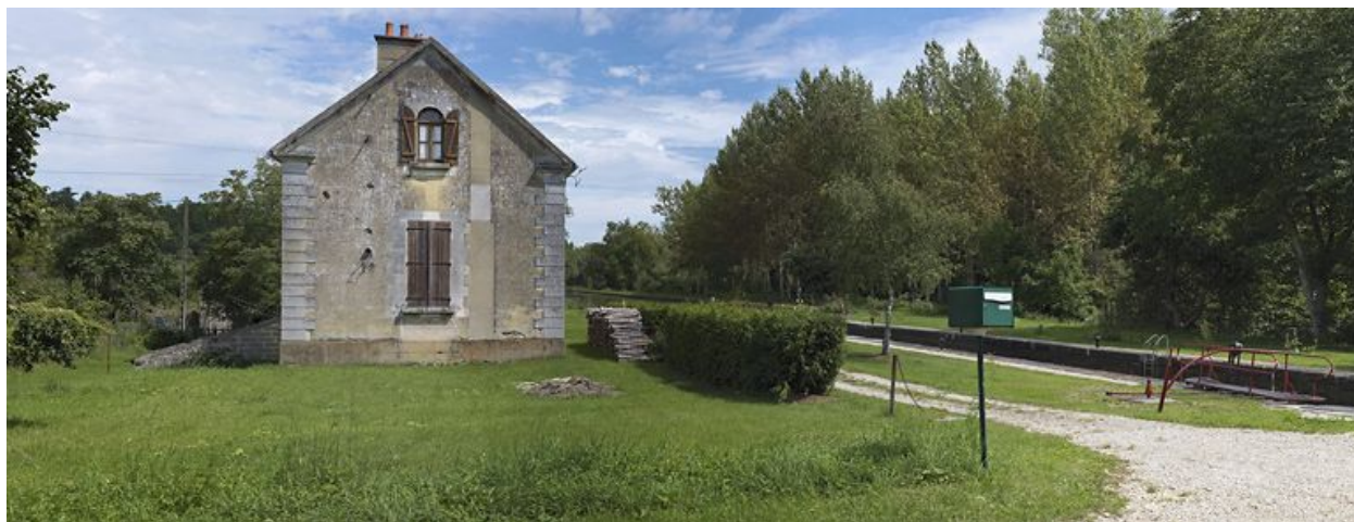
Maison éclusière : pignon regardant vers l'aval.
