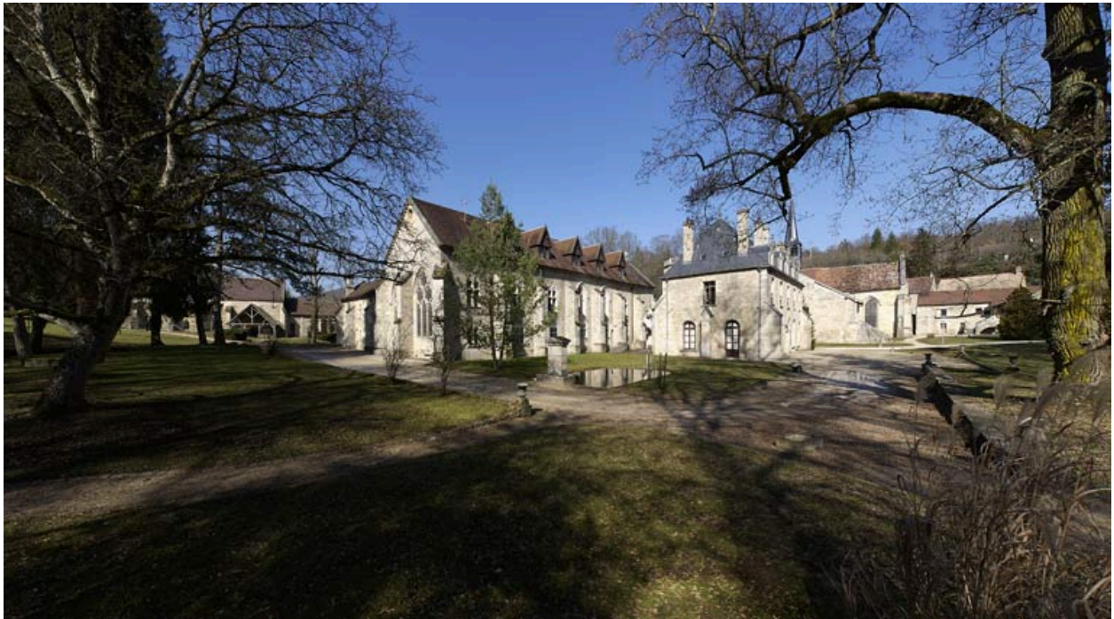
Bâtiments conventuels : vue d'ensemble depuis le sud-est.
