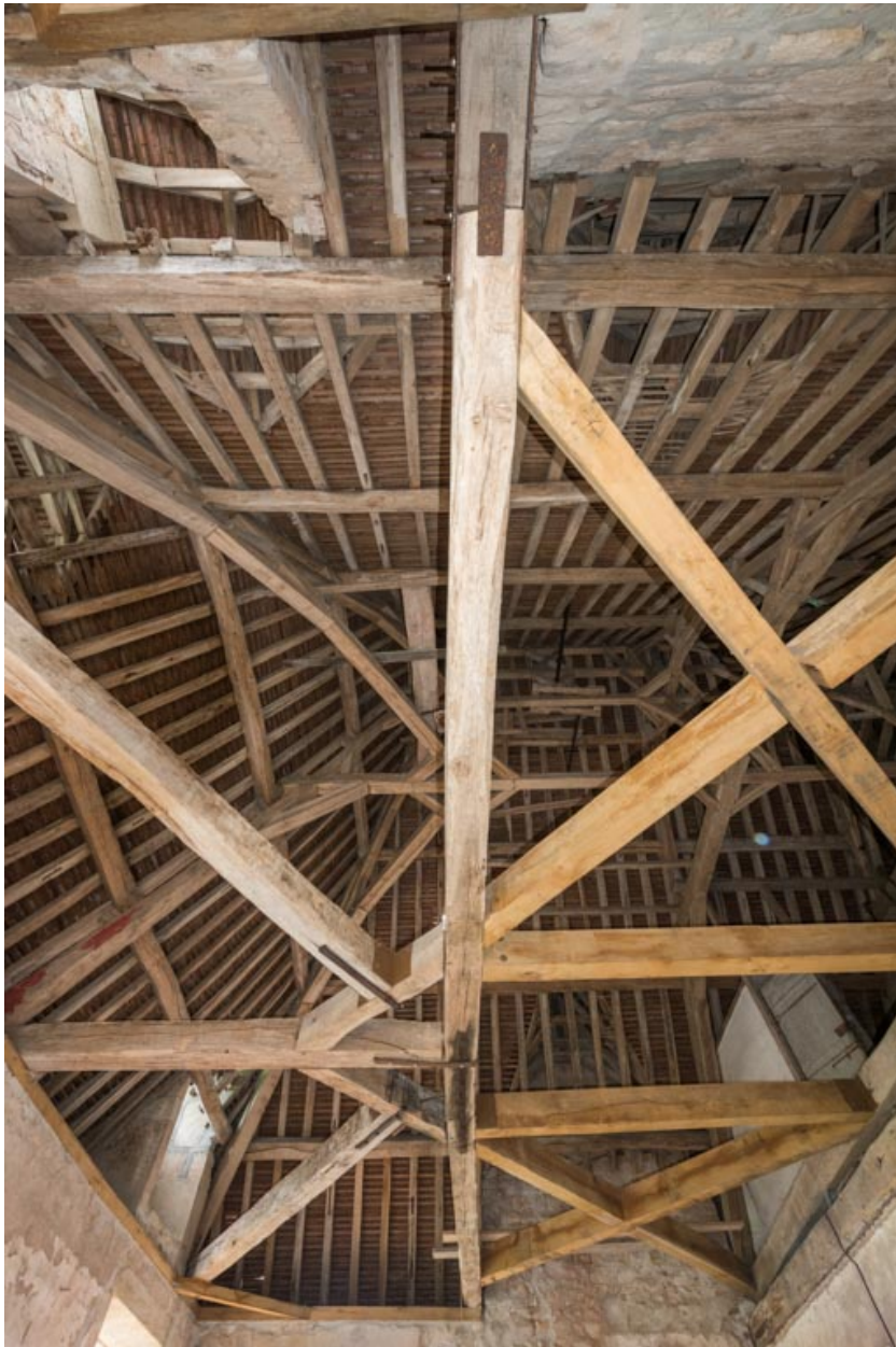
Charpente à chevrons portant-fermes, croupe sud-ouest, vue depuis le premier étage.
