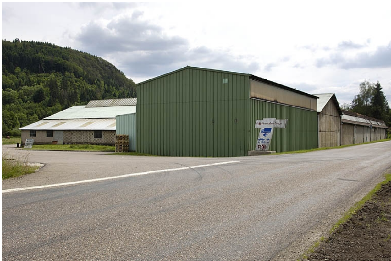
Extensions nord (entrepôts industriels).
