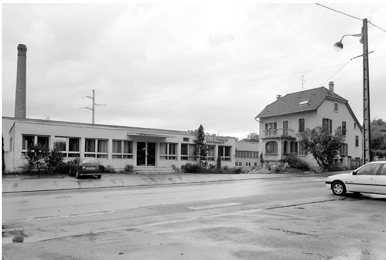
Bureaux et logement depuis le nord.
