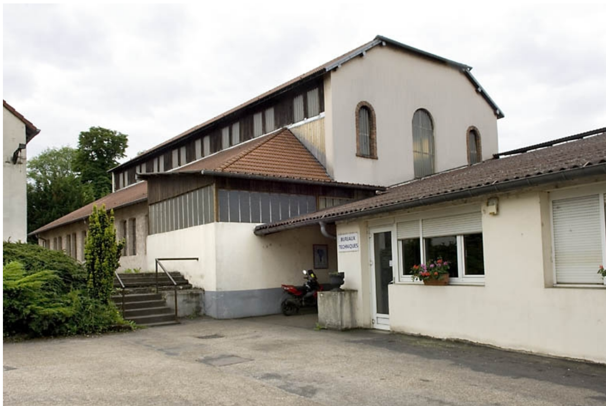
Atelier de fonderie depuis la cour.
