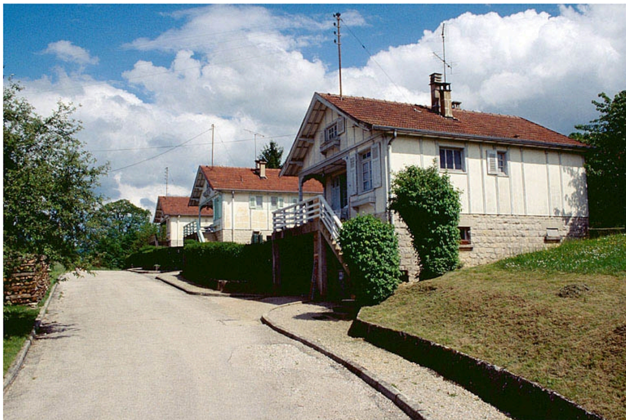
Logements d'ouvriers depuis l'ouest.
