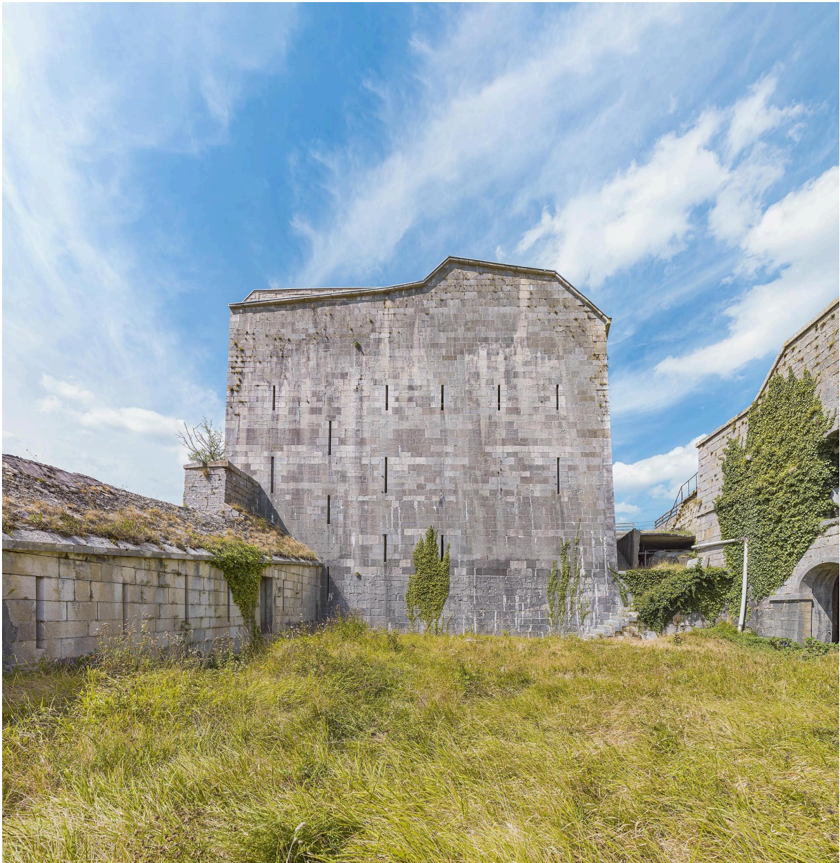
Mur pignon sud du réduit.
