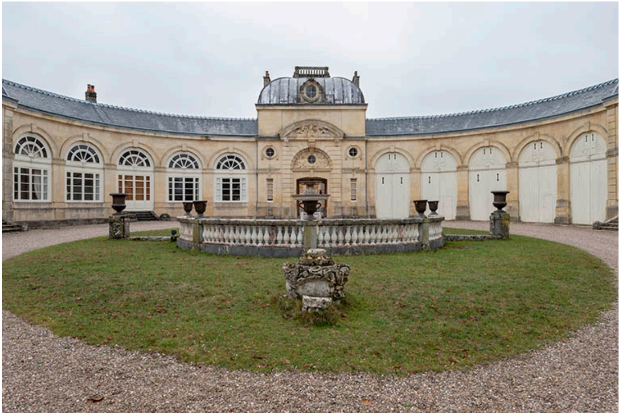
Fontaine et abreuvoir dans la cour de l'écurie, vue d'ensemble.
