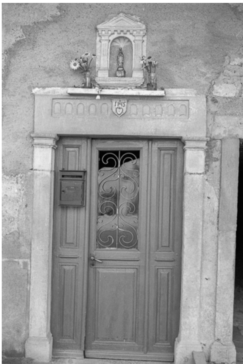
Porte d'entrée sur rue.
