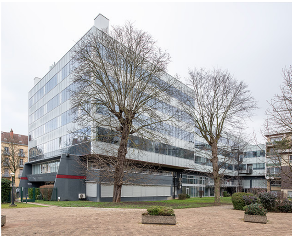
Façade sud-ouest et façade sud-est.
