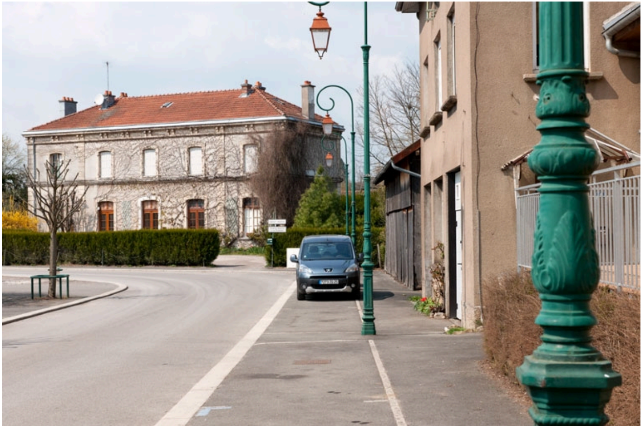
Vue générale de l'avenue et du bâtiment des voyageurs.
