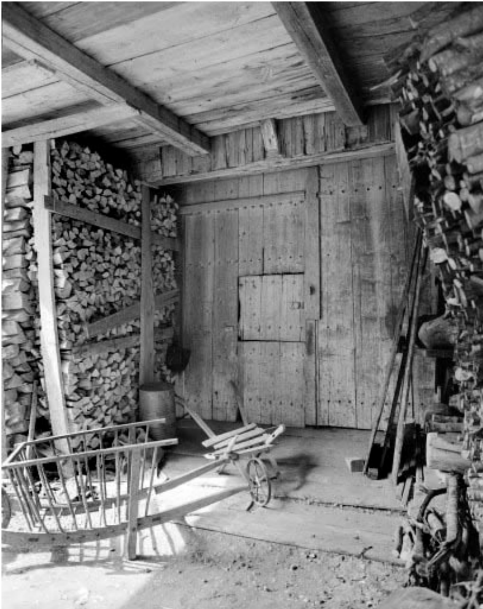
Façade postérieure : porte de grange.
