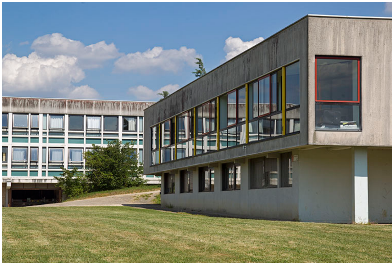
Angle nord-ouest du bâtiment d'internat de filles.
