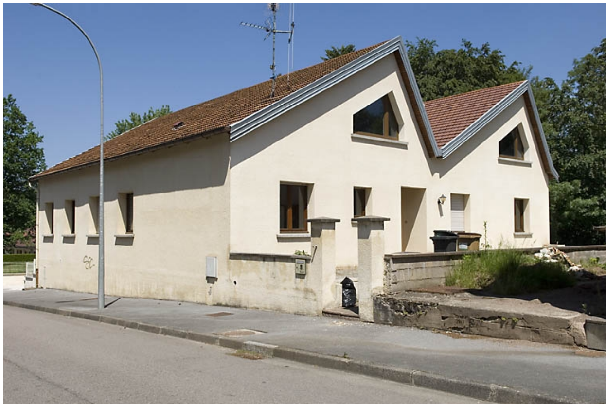
Ancien atelier de fabrication (polissage).
