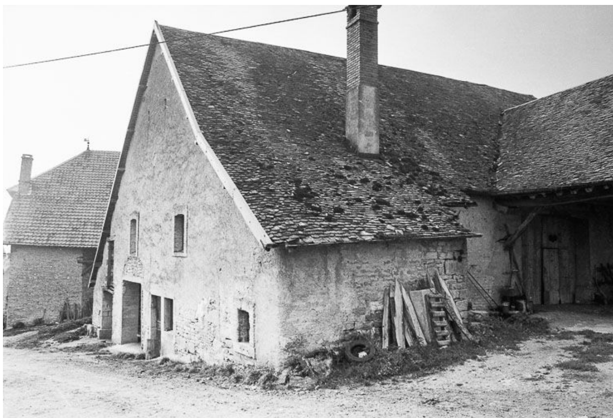
Ferme : vue de la partie habitation.
