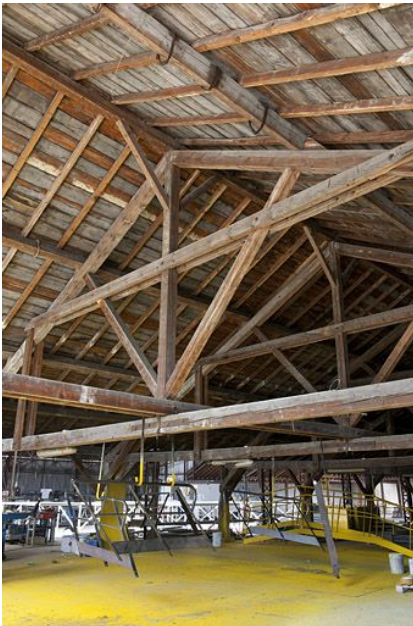
Entrepôt industriel. Charpente.
