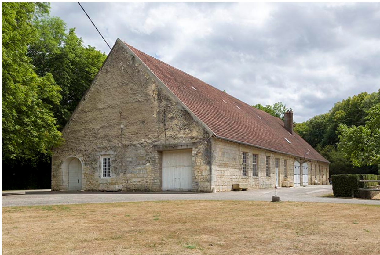
Vue de trois quarts de l'ancien manège.
