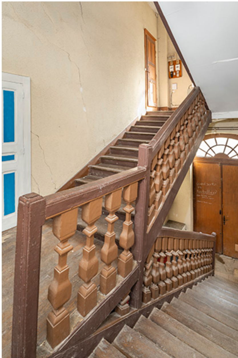
Escalier (n°3). Vue depuis l'entresol.
