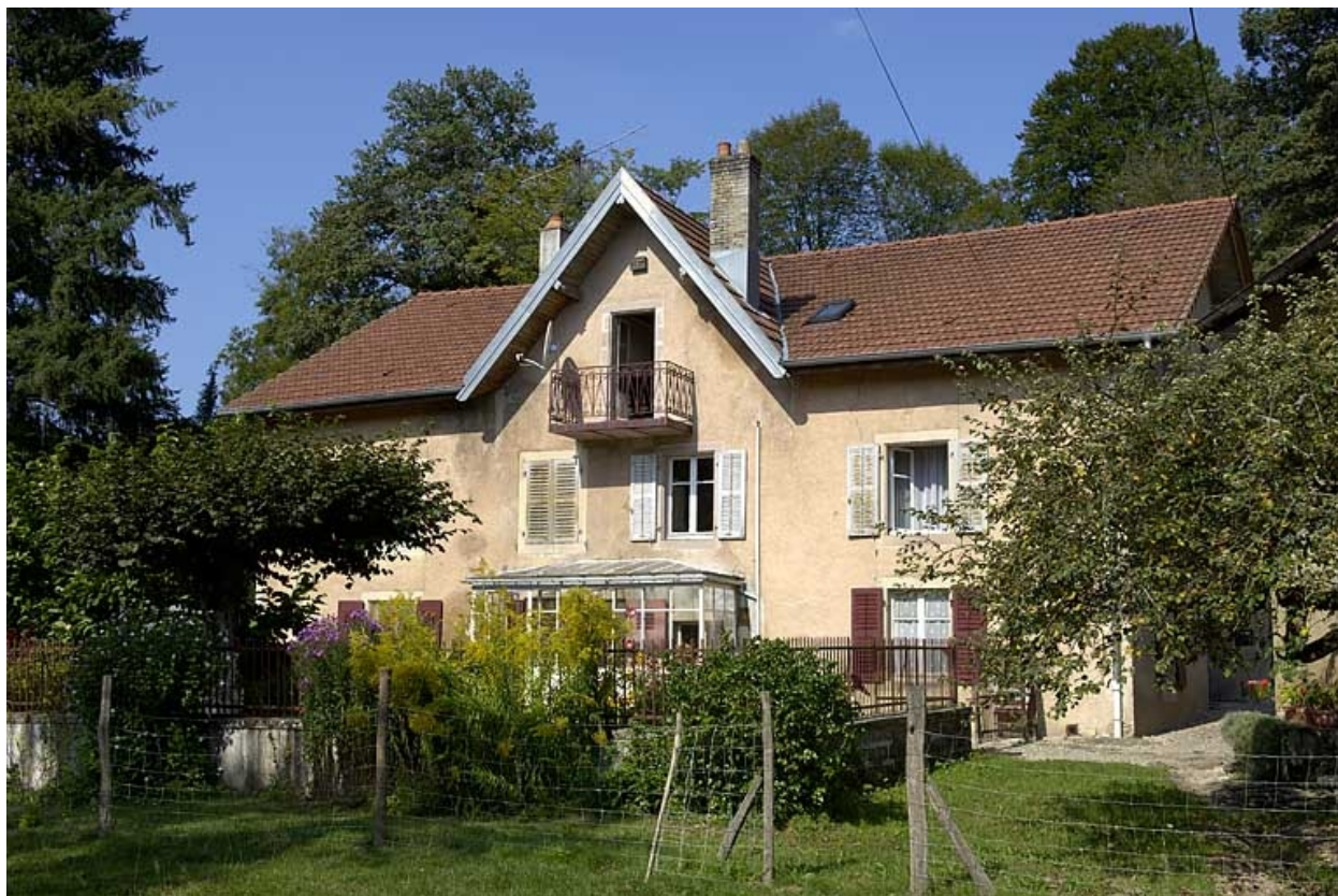
Façade sud du moulin.
