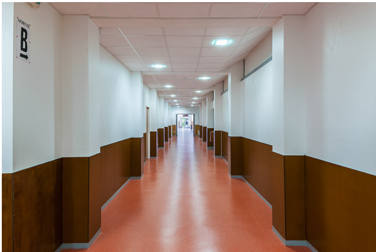
Couloir d'accès au hall d'entrée, rez-de-chaussée.
