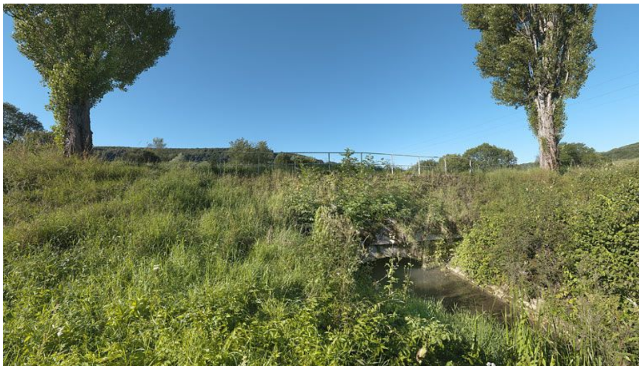
L'aqueduc du site d'écluse 16.
