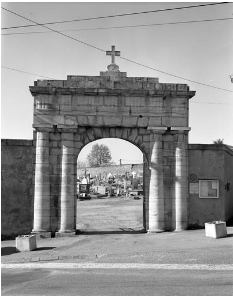
Vue du portail d'entrée : de face.
