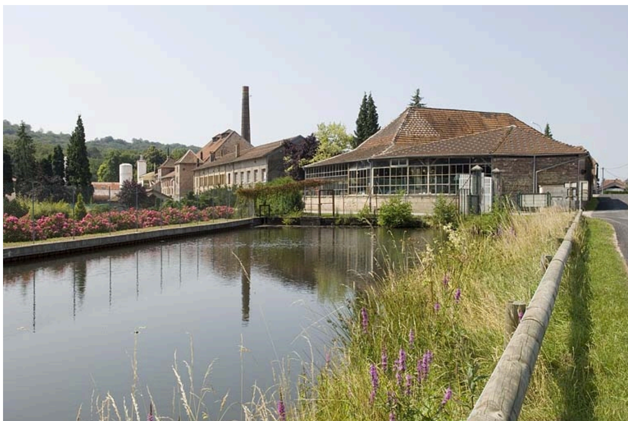
Verrerie de la Rochère : bassin de retenue et ateliers.
