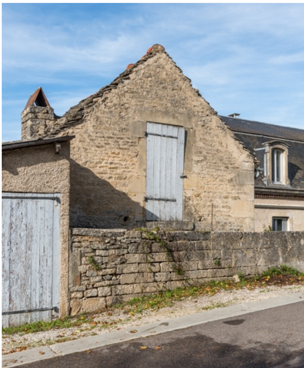
Détail du mur pignon sud.
