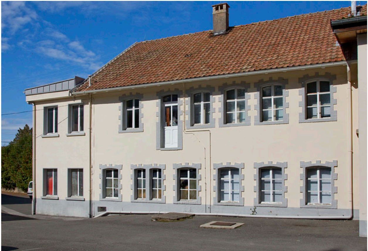
Atelier rehaussé en 1923-1924 : façade latérale droite.
