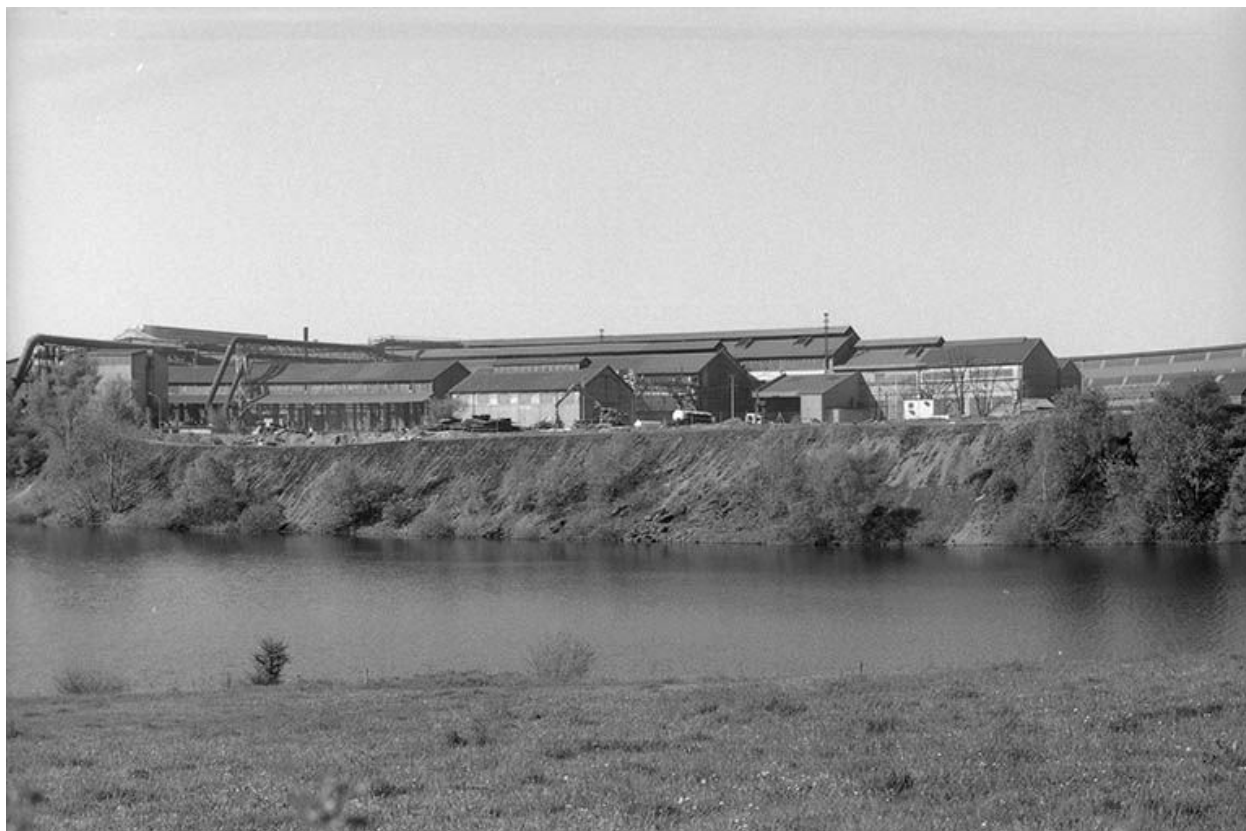
Vue de l'aciérie depuis le nord-est.
