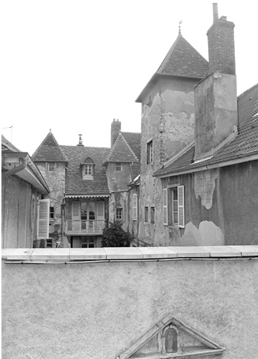
Vue partielle des façades sur la cour.
