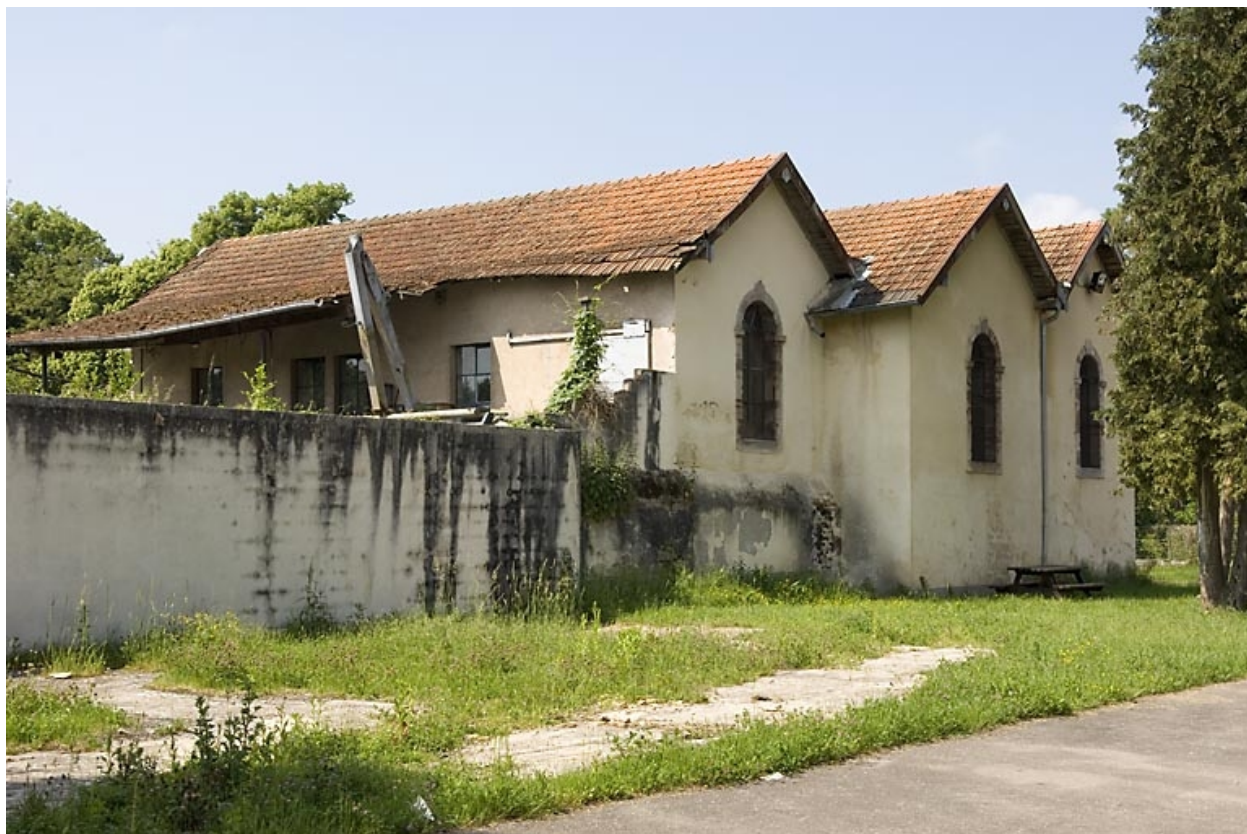
Centrale hydroélectrique. Vue de trois quarts arrière.
