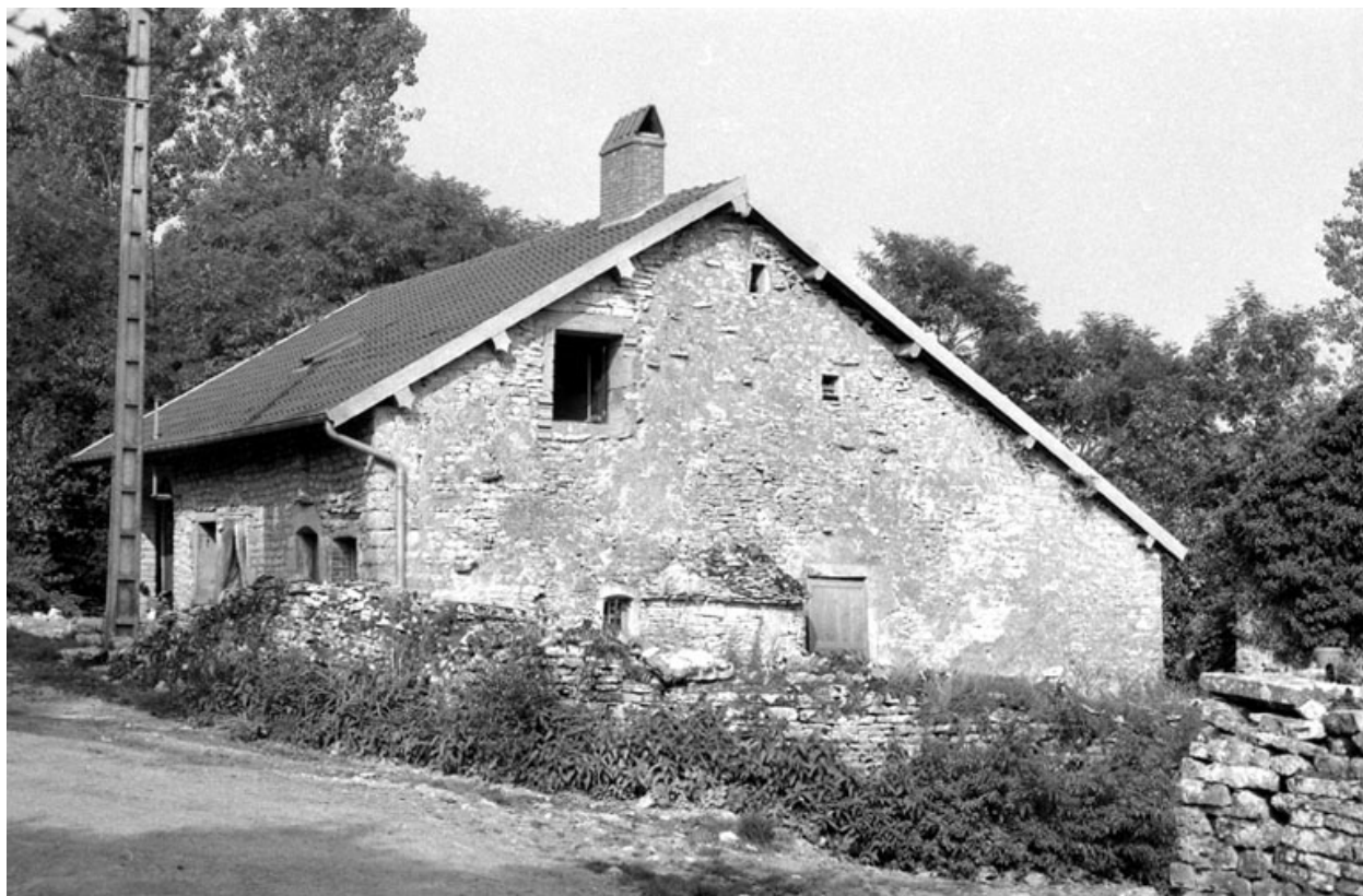
Façade latérale droite.
